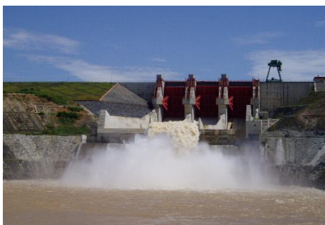
Da Nhim Spillway
